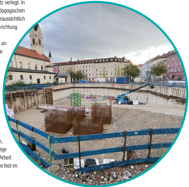
Der Baufortschritt ist deutlich zu sehen.
