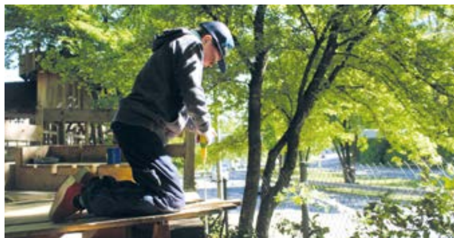
Im Baubereich wird hart gewerkelt
