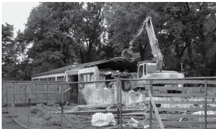
Abriss des Jugendtreff Harthof - Platz für ein neues Haus entsteht.
