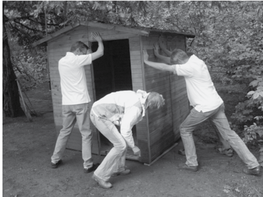
Auch kleine Häuser müssen gerade stehen. Freiwillige beim Aufbau eines Gartenhäuschens.
