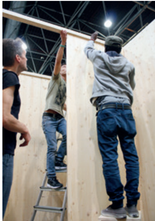
Bau des Messestandes für den 16. DJHT
