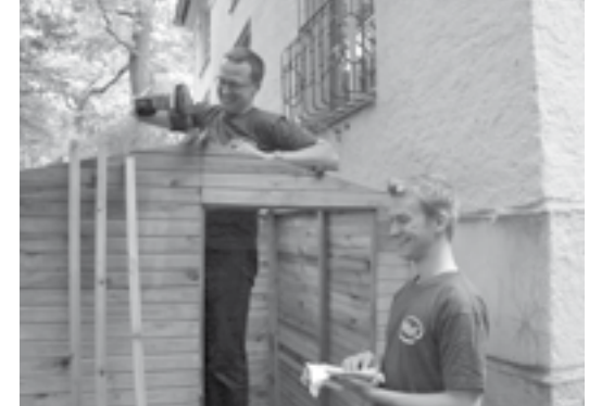
Engagierte Freiwillige der Firma Intel bauten auf dem Gelände des Rumfordschlössls eine Hütte auf.
